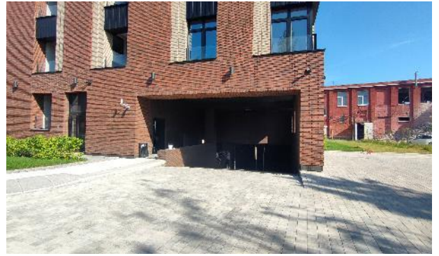
Фото 6. Въезд в подземный паркинг
