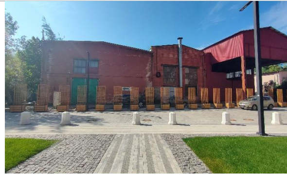
Фотография 3.8. Придомовая территория
