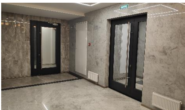
Фото 175. Места общего пользования.
