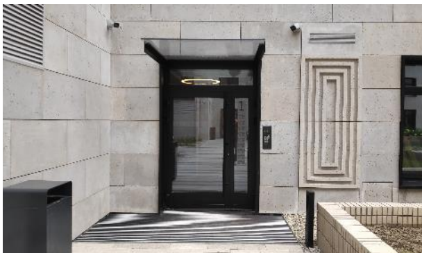
Фото 197. Места общего пользования.
