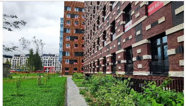
Фотография 3.8. Придомовая территория
