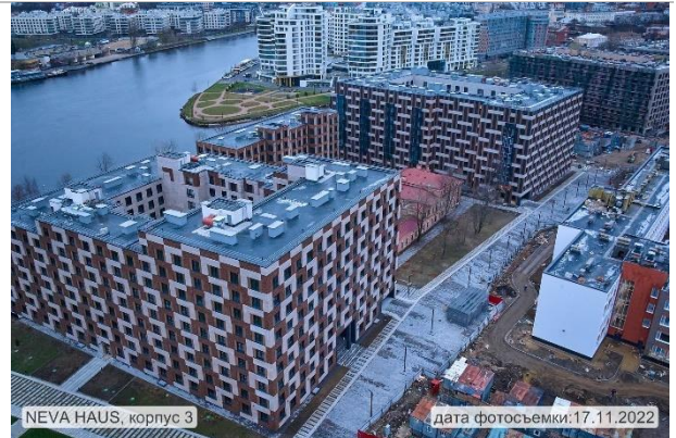
Фотография 3.2. Жилой дом по адресу г. Санкт-Петербург, пр. Петровский, д. 11, корп. 3, стр. 1
