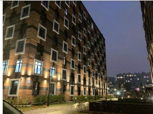
Фотография 3.18. Жилой дом по адресу г. Санкт-Петербург, пр. Петровский, д. 9, корп. 2, стр. 1
