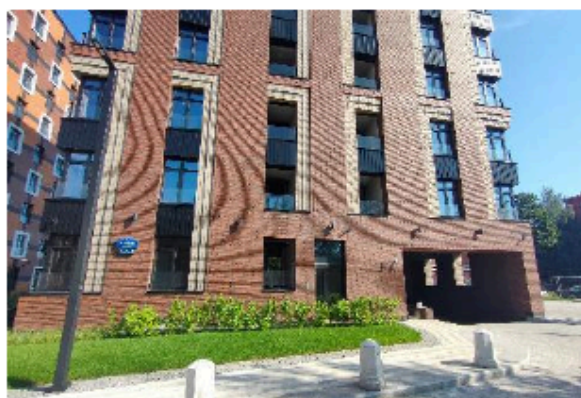
Фото 5. Въезд в подземный паркинг
