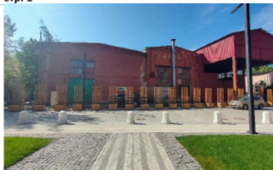
Фотография 3.12. Придомовая территория
