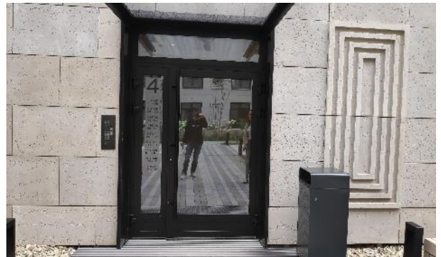
Фото 284. Места общего пользования.
