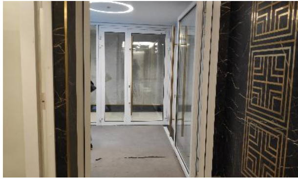
Фото 281. Места общего пользования.
