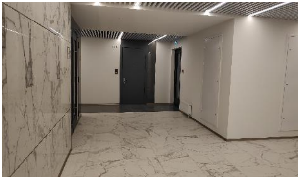
Фото 269. Места общего пользования.
