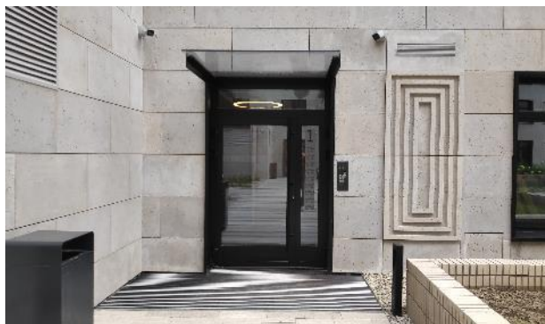
Фото 289. Места общего пользования.
