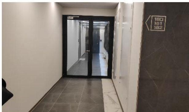
Фото 273. Места общего пользования.
